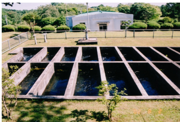
浄水場の中のようなす（左が浄水池、右がろ過 か 池）
