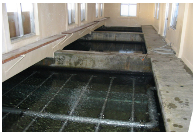
浄水場の中のようなす（左が浄水池、右がろ過 か 池）
